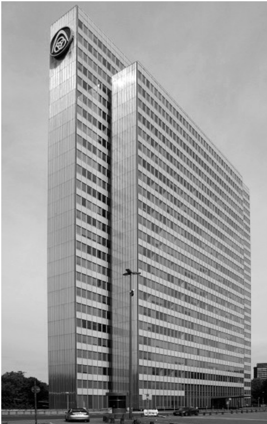
68. Ingreso a la Thyssen. Recibe al visitante una marquesina sobre las escalinatas de acceso
