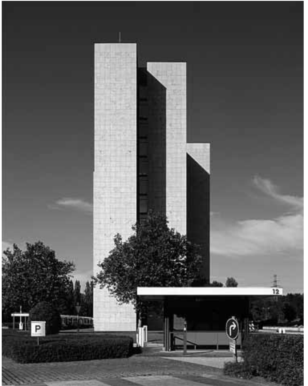
132. Central Eléctrica. Vista del edificio desde el sur.
