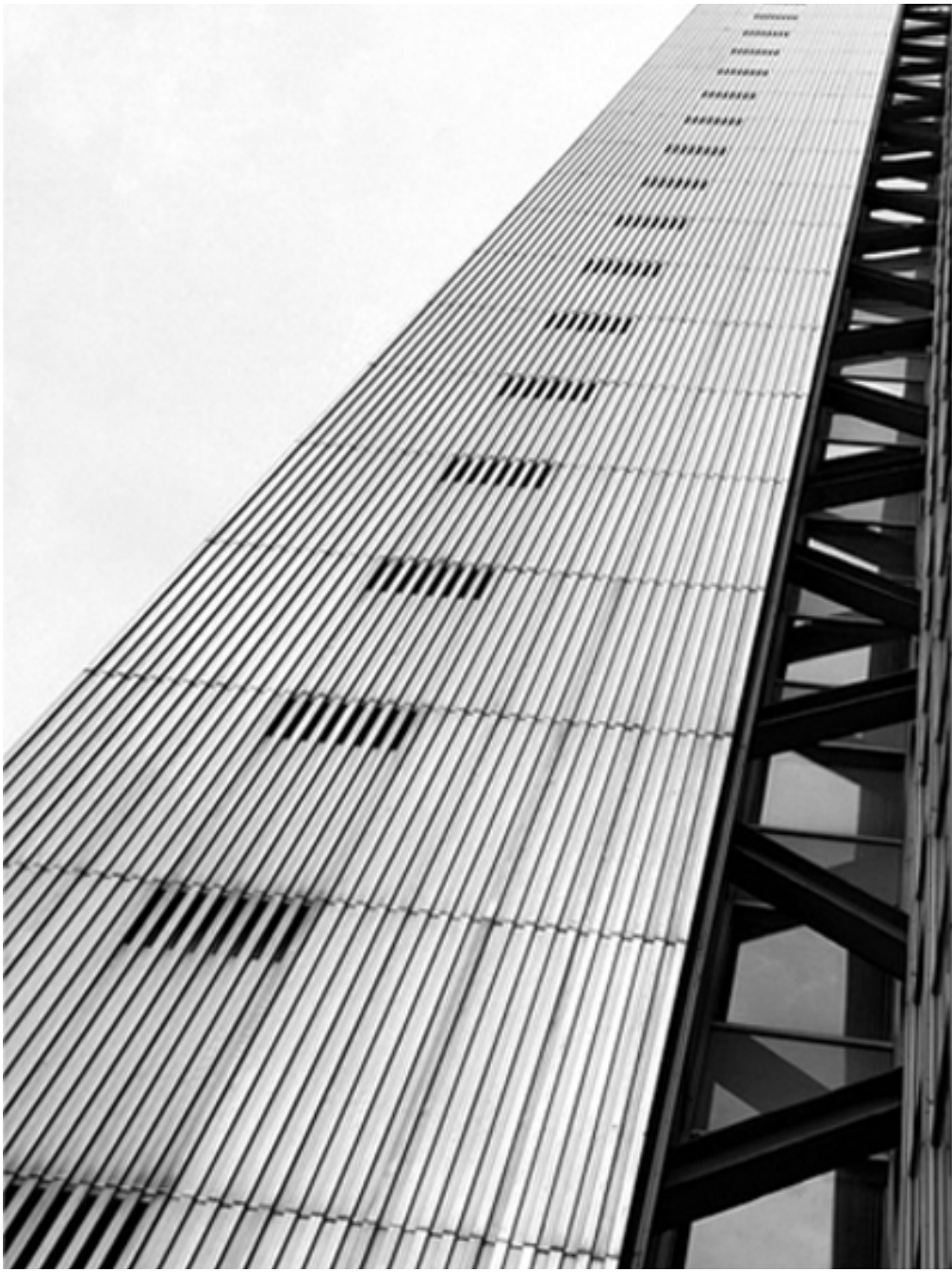
137. Detalle de fachada Thyssenhaus
