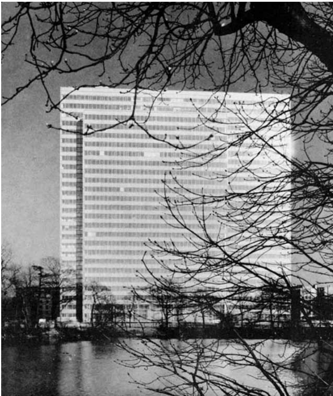
129. Thysenhaus desde el Hofgarten. Vista de la fachada lateral - muro cortina
