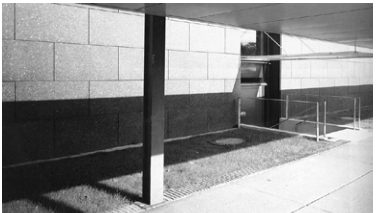
64. (pag. 46 superior) Marquesina de ingreso al edificio Thyssen 65. (pag. 46 inferior) Vista frontal de las escalinatas y marquesina 66. Vista desde el interior de la pérgola de ingreso a la HEW 67. Ingreso a dependencias de la HEW a través de pérgola
