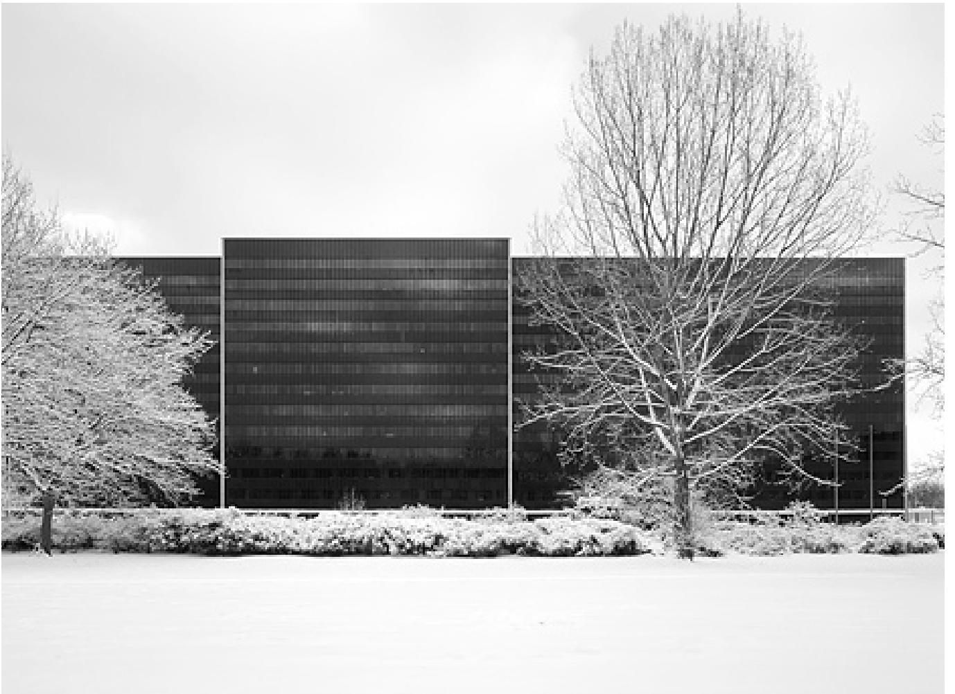
22. Vista de la Central Eléctrica de Hamburgo desde el oeste
