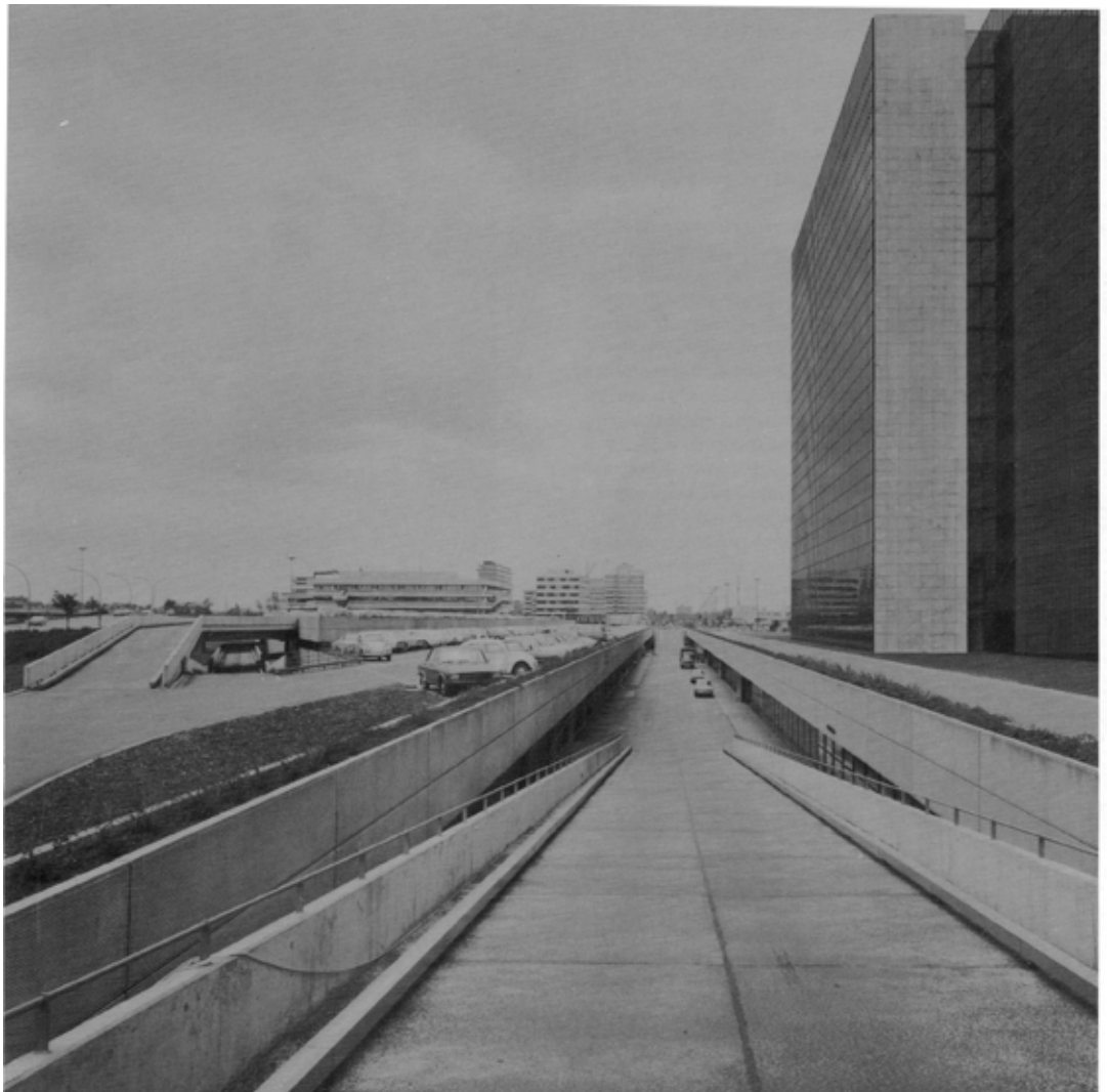
77. Rampa en un tramo – calle de servicio - ingreso al parking de la HEW
