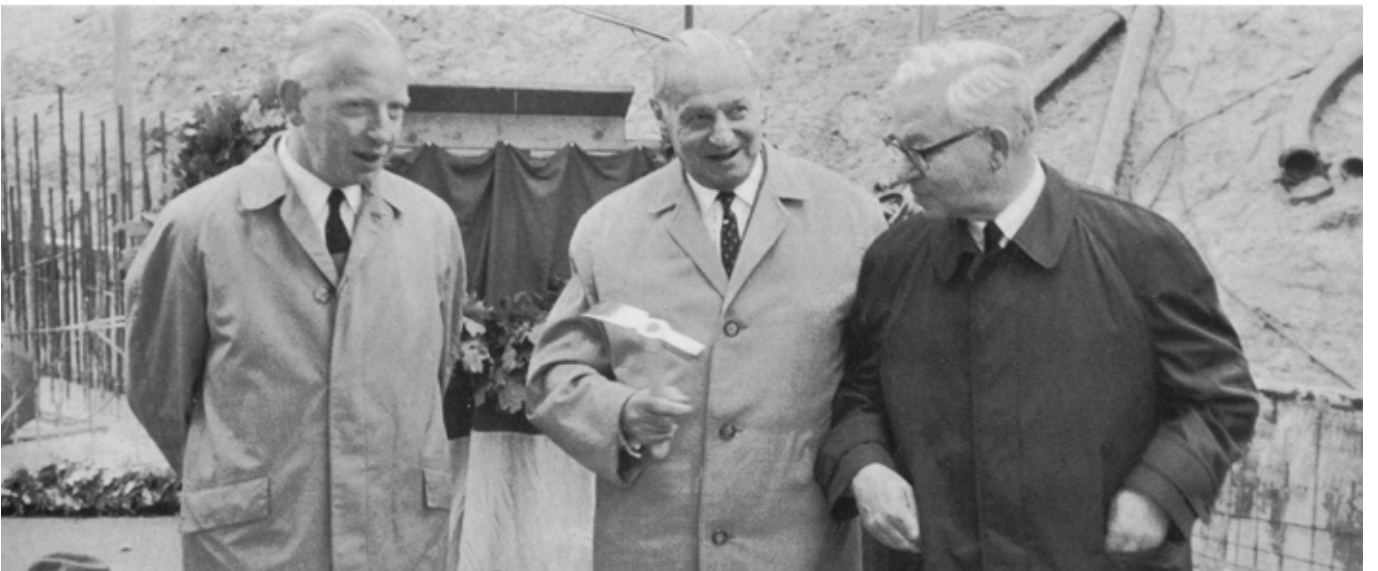
167. Jacobsen en una visita de obra a la Central Eléctrica
