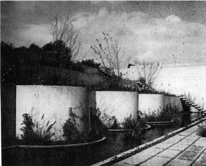
61. Terraza continua al área de comedor ubicado en el subsuelo de la Central Eléctrica
