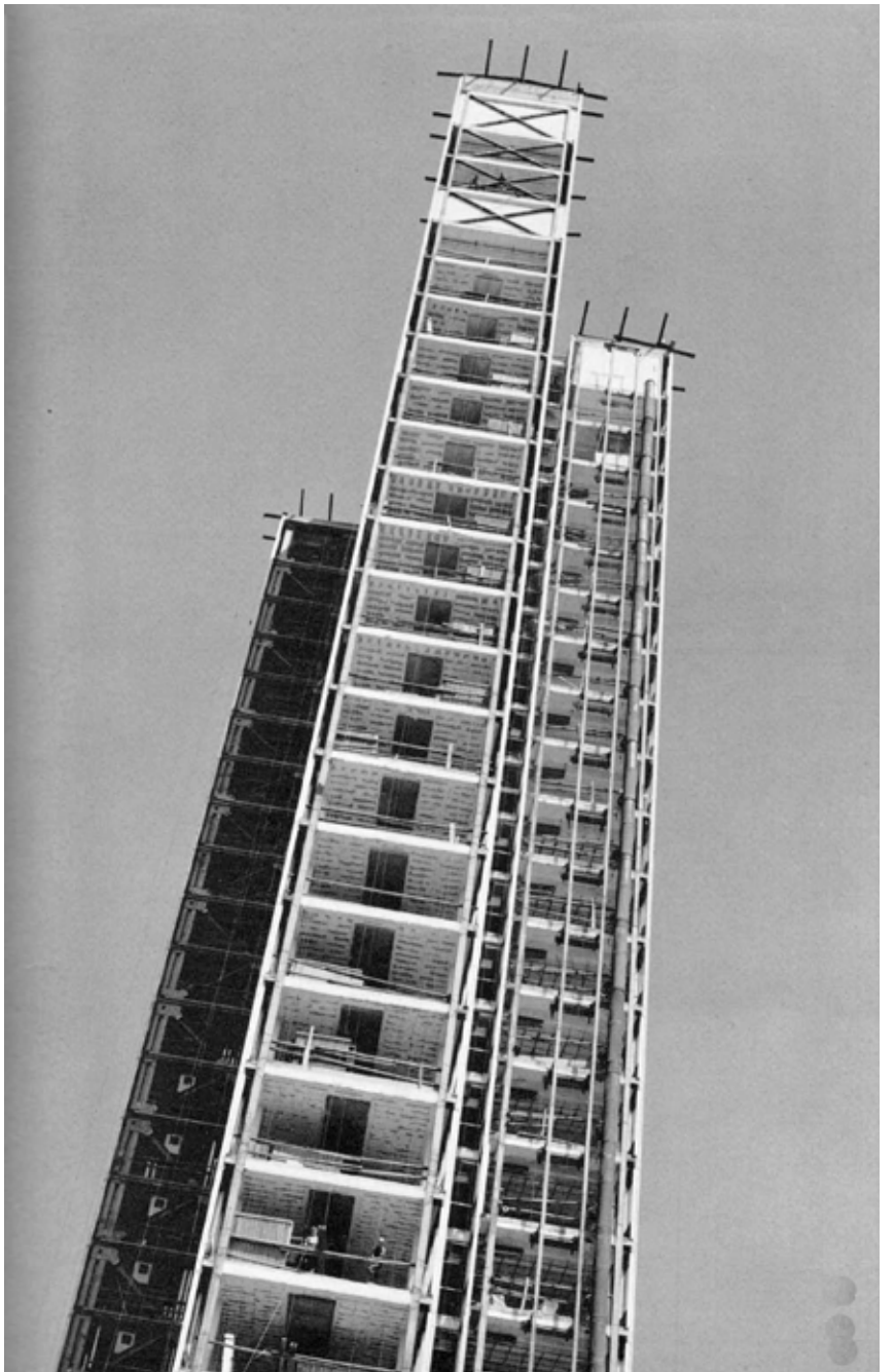
116. Vista sur Thyssenhaus. Montaje de las cruces de San Andrés en testeros
